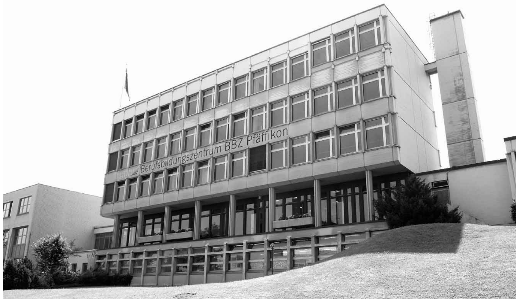
Soll für 15,9 Mio. Fr. saniert werden: die Schulanlage Schützenstrasse des Berufsbildungszentrums Pfäffikon.
