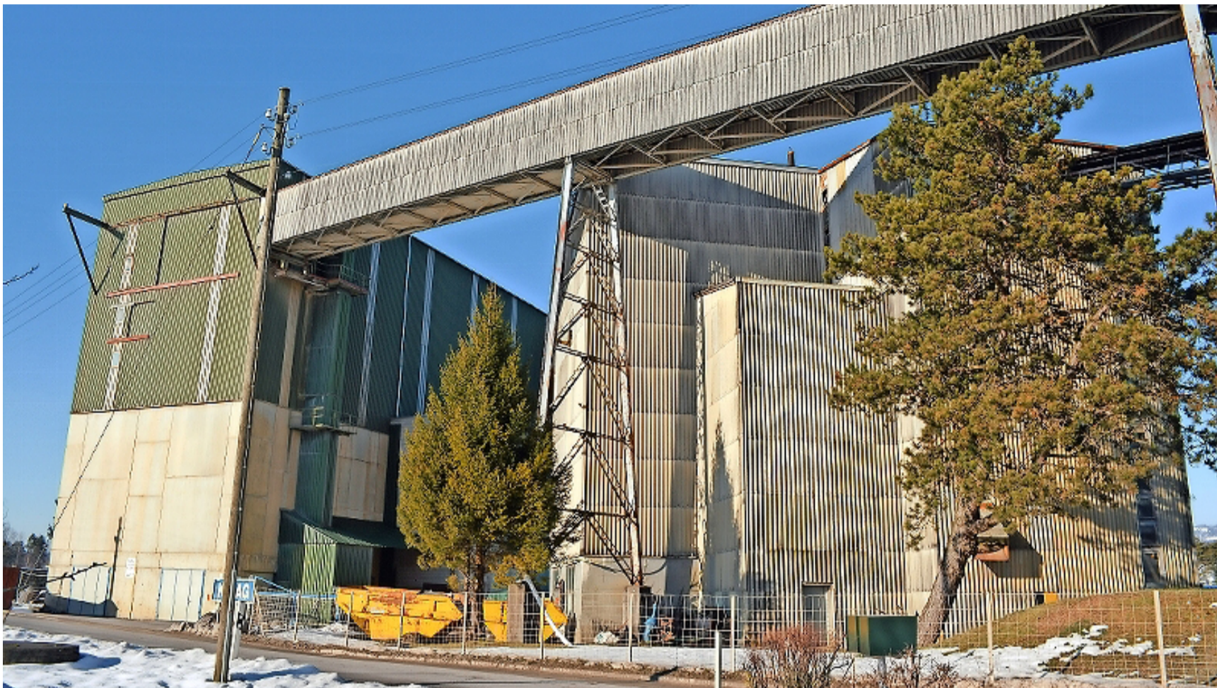
Die Kibag hat sich verpflichtet, sein Nuoler Betonwerk direkt am See bis 2014 abzureissen. Mit fraglichen Argumenten will sie jetzt den Vertrag nicht einhalten.
